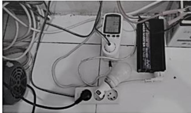
Gambar 7. Pengukuran pemakaian peralatan listrik.
