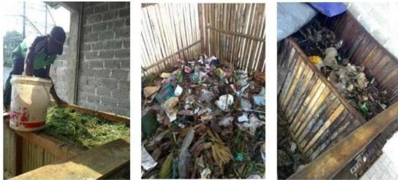
Ket : Proses memasukan sampah kedalam bak proses komposting (foto kiri dan tengah) dan peninjauan selama proses komposting (foto kanan)
