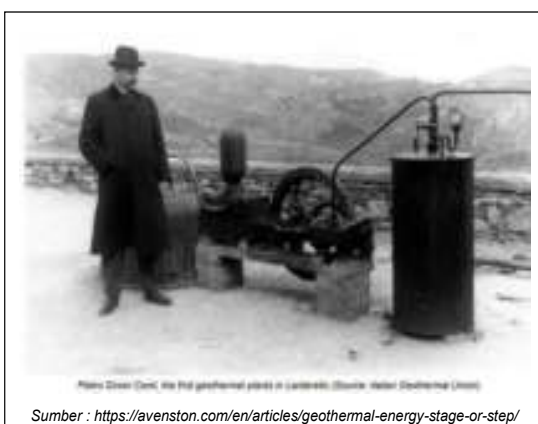
Gambar 6.1. Generator listrik tenaga uap panas bumi pertama di Lardelero
