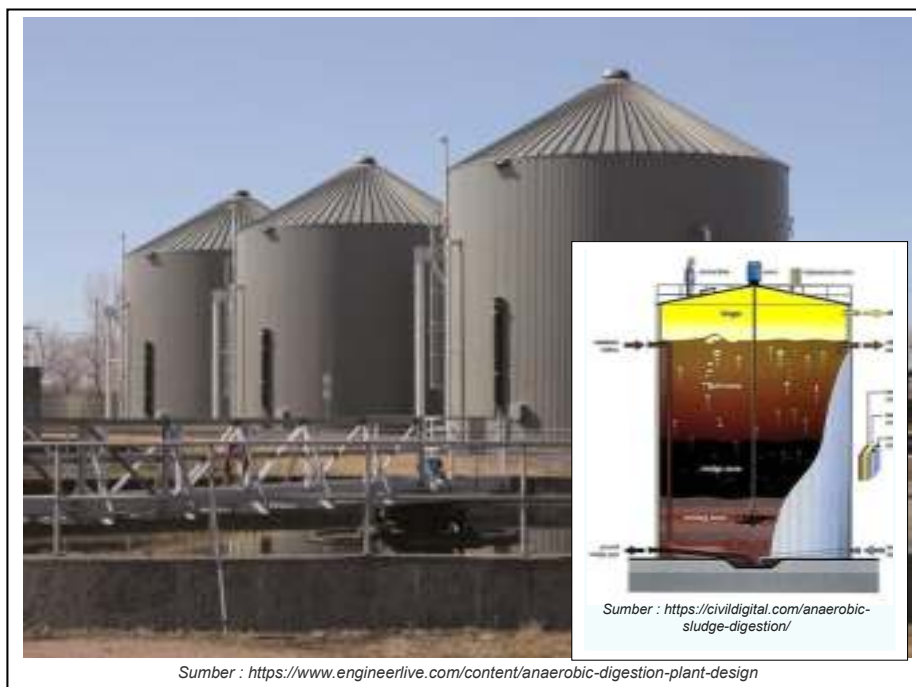
Gambar 9.13. : Contoh instalasi Anaerobic Digester berskala besar
