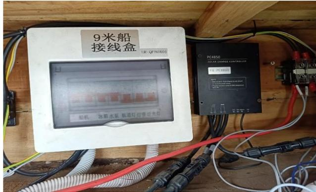
**Gambar 7.** Pemeriksaan Kotak MCB, Sekring dan Jalur ground pada Combiner Box
