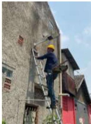
**Gambar 6.** Pemasangan Lampu LED tenaga surya
