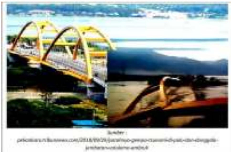
**Gambar 5.34.** : Jembatan Vatulemo yang runtuh digoncang gempa dan diterjang *tsunami*
