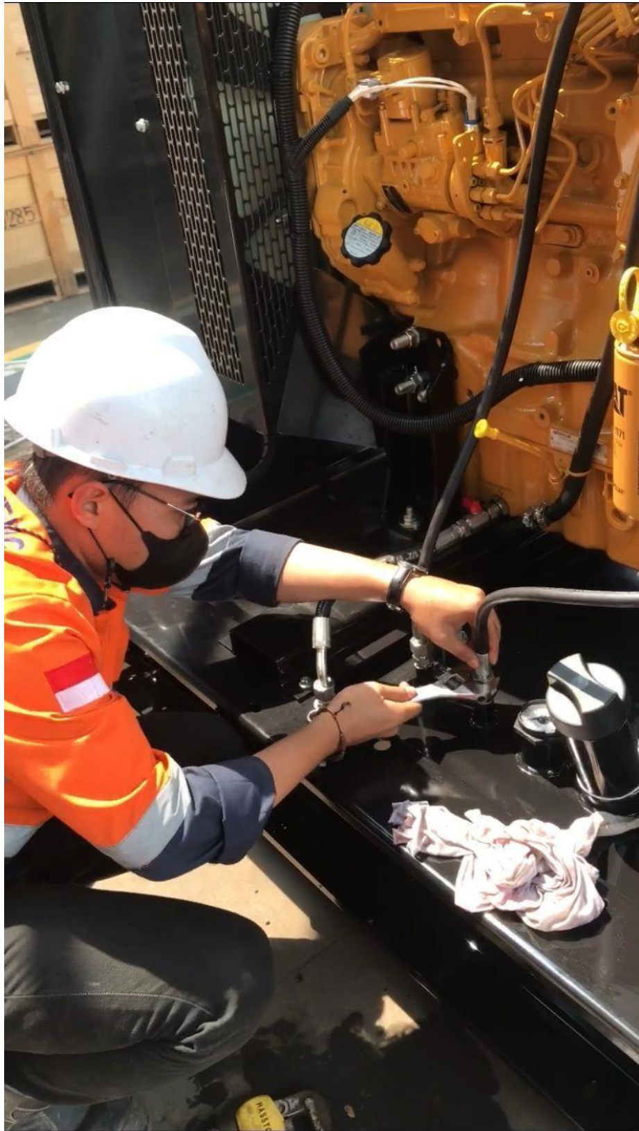
Gambar Mengecek dan Pengisian Bahan Bakar Solar
