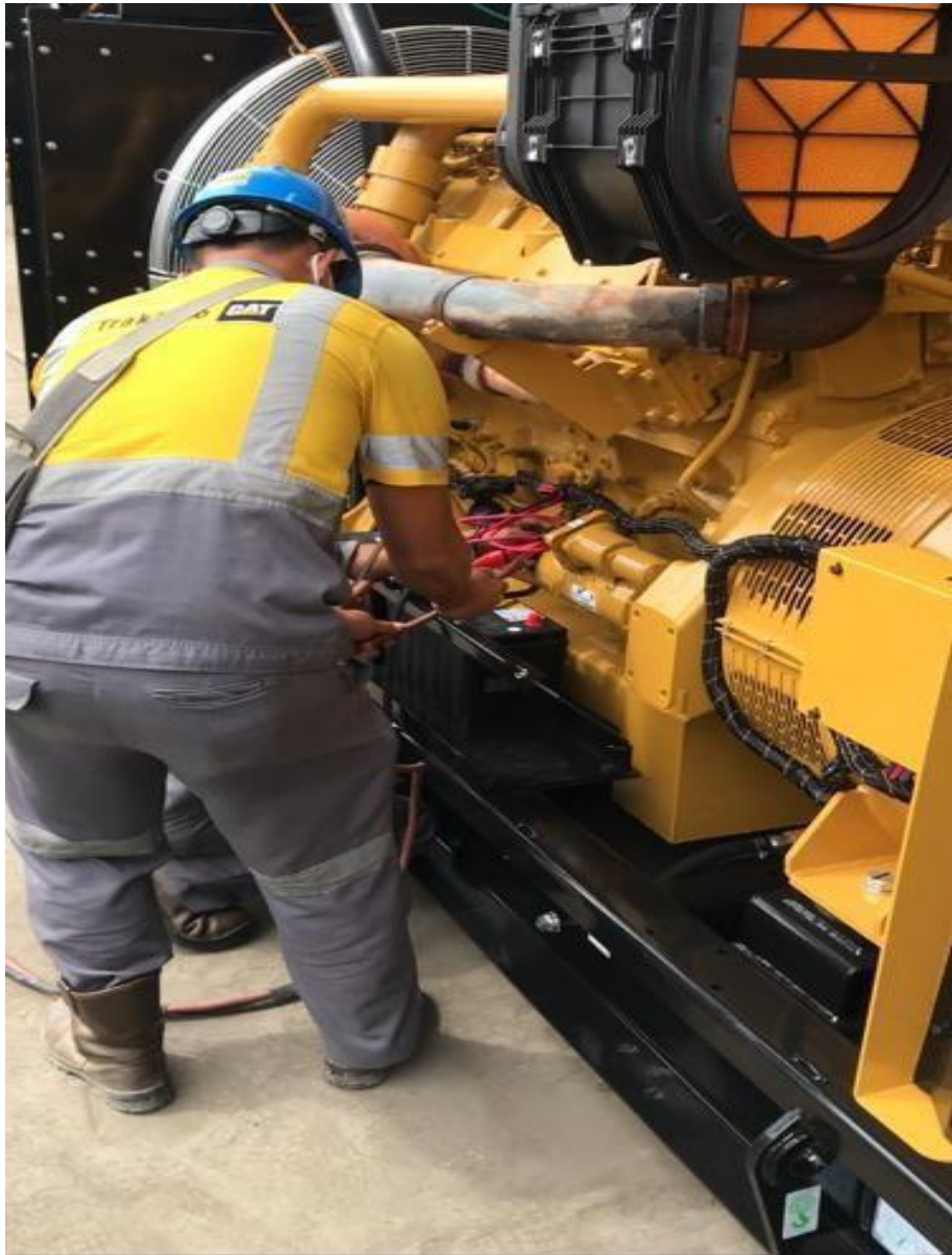
Gambar Pemasangan ACCU atau Aki pada Genset
